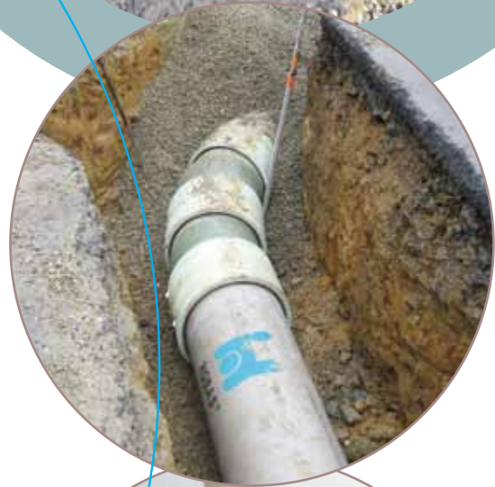
Système de raccord résistant à la traction HOBAS (au milieu) mis en œuvre et schématisé (en bas à droite). Etanchéité garantie à haute pression et dans des sols marécageux.
